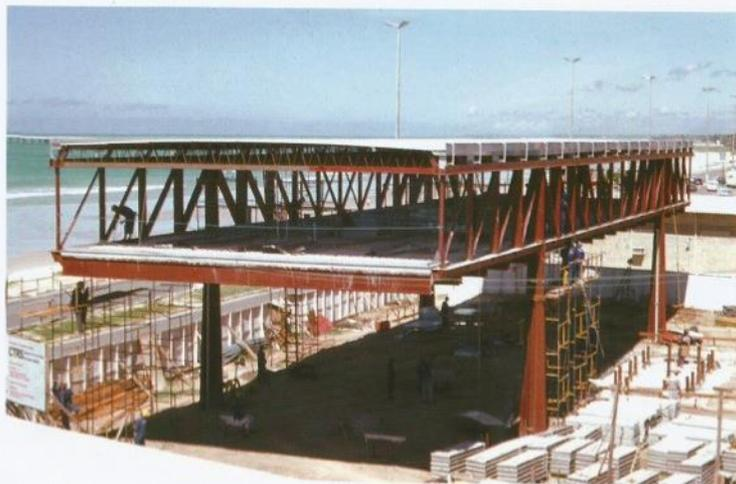
Vista da fase final de montagem da estrutura de cobertura com as telhas de alumínio
